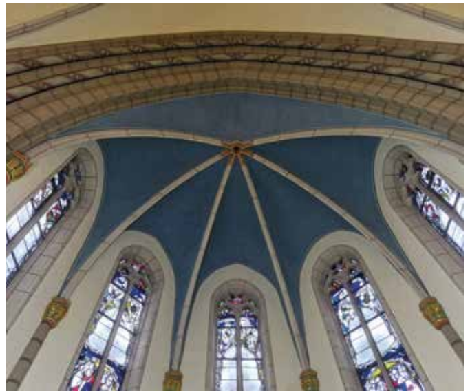
fertiges Chorgewölbe; Quelle: privat
